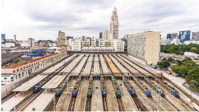
Fig.10- Foto: Estação central.
