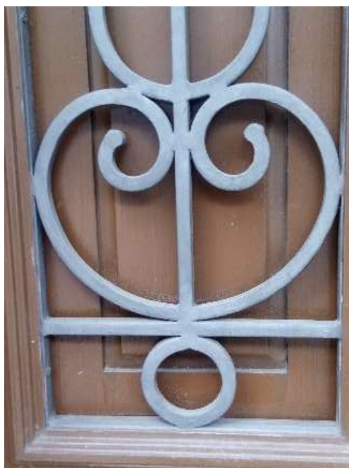
Imagem 12 – Porta de madeira, com detalhes em ferro. Imóvel situado no centro do Rio de Janeiro
