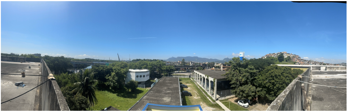
Figura 3: imagem do campus escolar visto do terraço.
