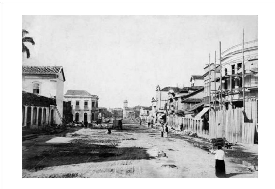
Figura 48: Obras de unificação da antiga Rua Estreita de S. Joaquim, com a antiga Rua Larga de São Joaquim (atual Av. Marechal Floriano)
