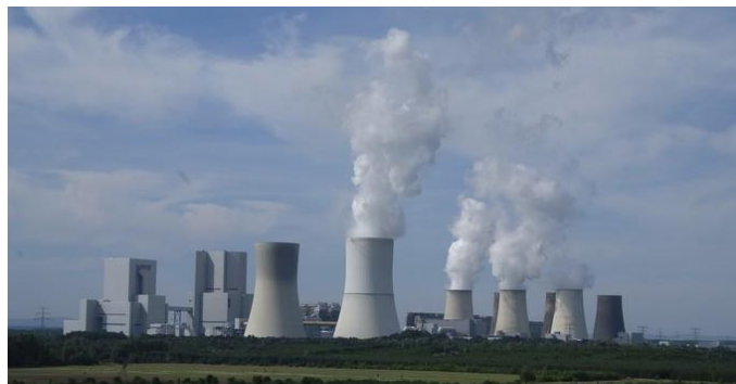
Figura 22 - Torres de resfriamento de uma usina nuclear
