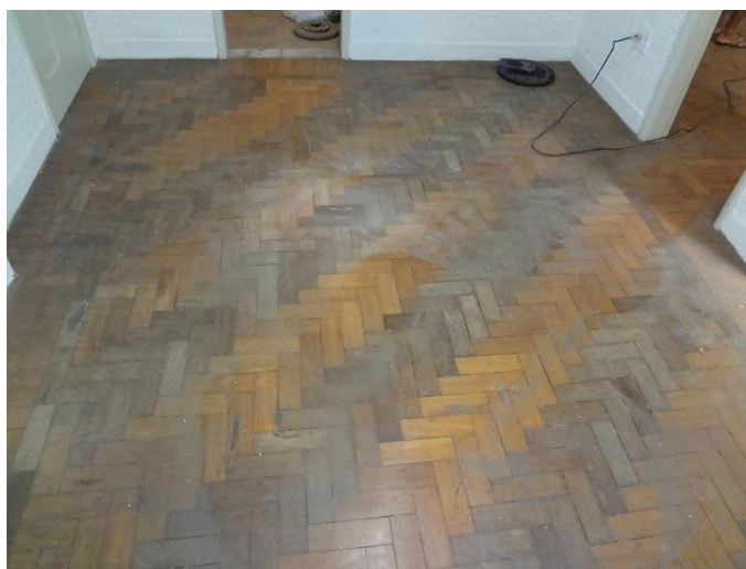
Figura 3: Piso de madeira
