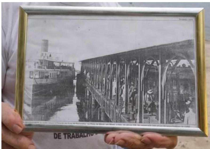
Figura 12 - Embarcação atracada no Porto Mauá próxima a um trem estacionado
