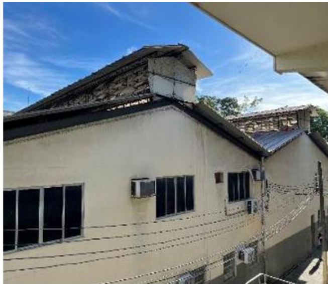
Imagem 11- Antigo depósito embalagens FENAME. (foto interna e externa - atual escola). Sistema de ventilação e iluminação natural Lanternin -ref. arquitetura fabril.
