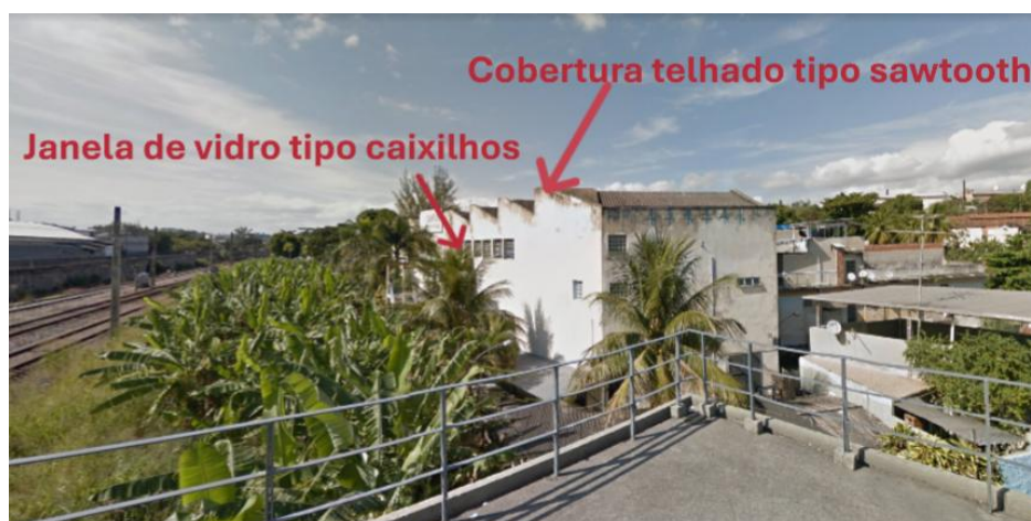
Imagem 8 – Foto na passarela Metrô Maria da Graça com vista para o CEFET Maria da Graça. Vista de elementos arquitetônicos da FENAME
