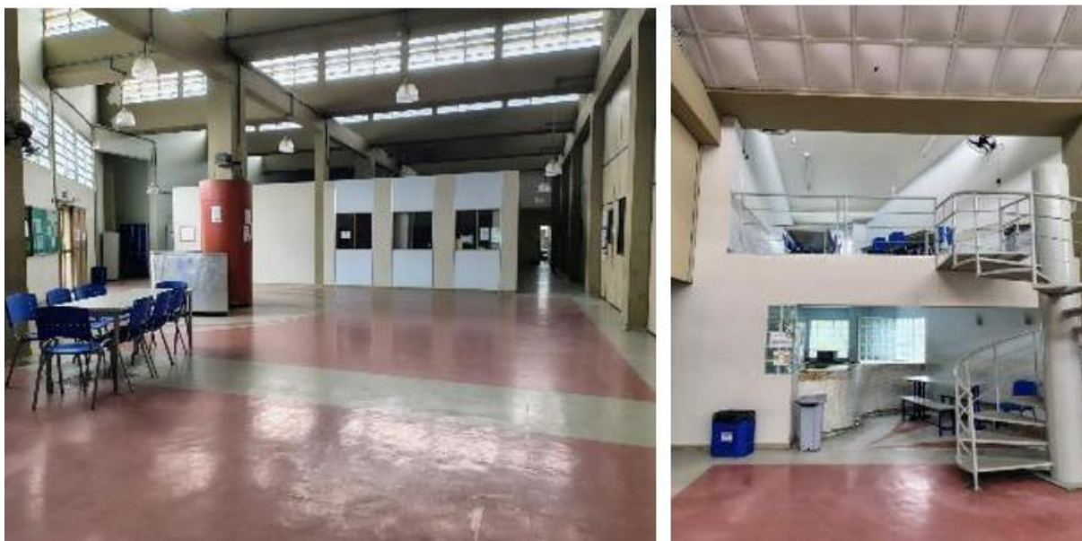
Imagem 10 - CEFET Maria da Graça (vista interna Bloco F – Espaço convivência – Pé direito alto) e telhado tipo dente de serra, com iluminação e ventilação natural.
