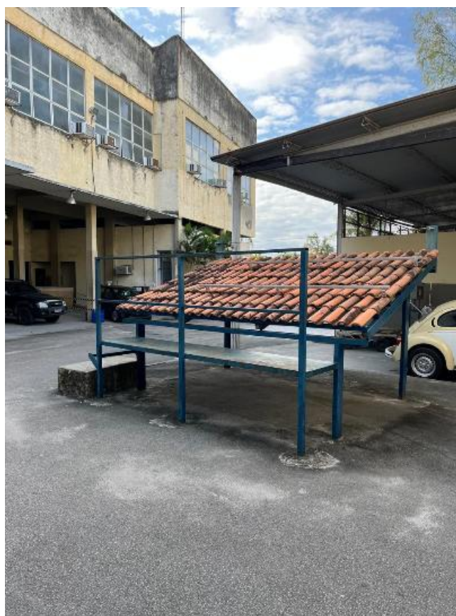
Imagem 13 - Projeto – oficina módulos painéis fotovoltaicos
