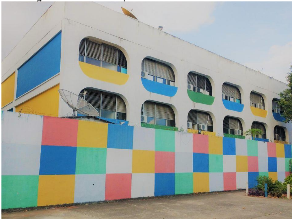
Figura 4: Entrada do Ciep 244
