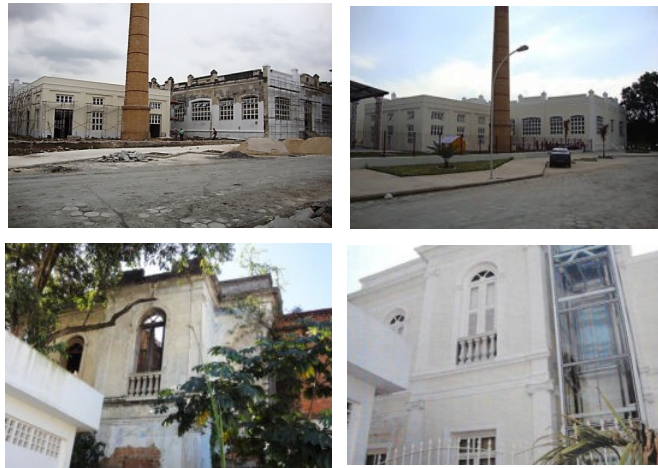
Figura 12: A reforma dos prédios do Colégio Pedro II, em Realengo (RJ).
