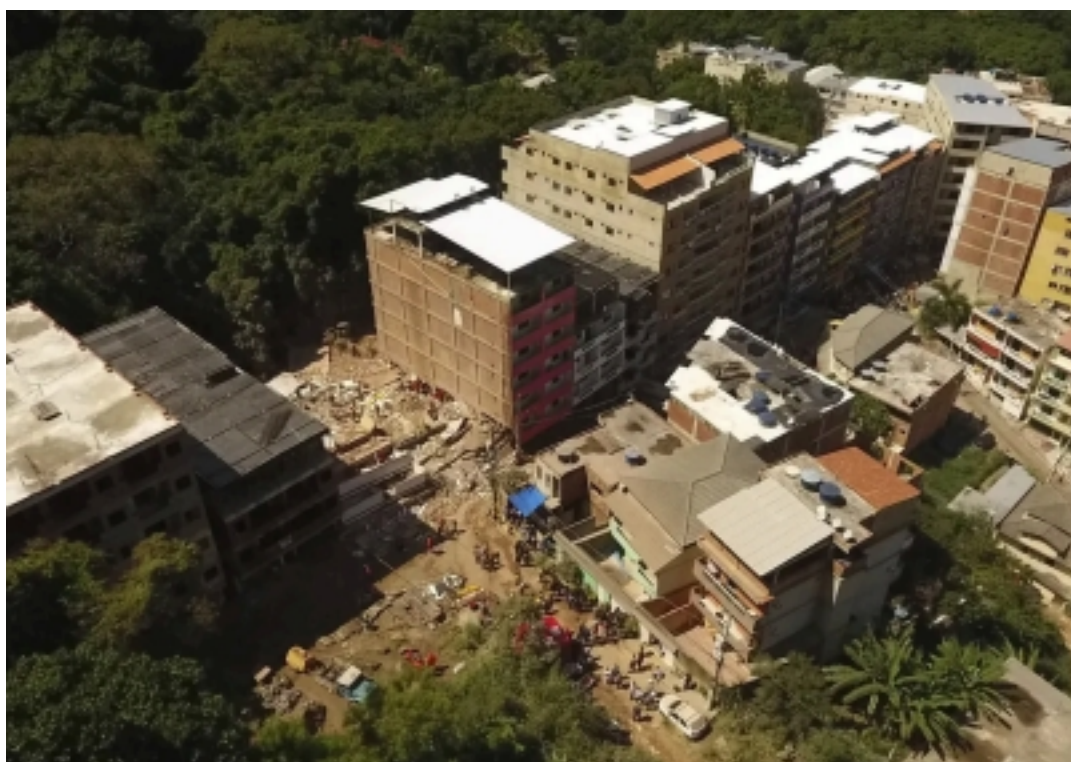
Figura 13 - Escombros na Muzema
