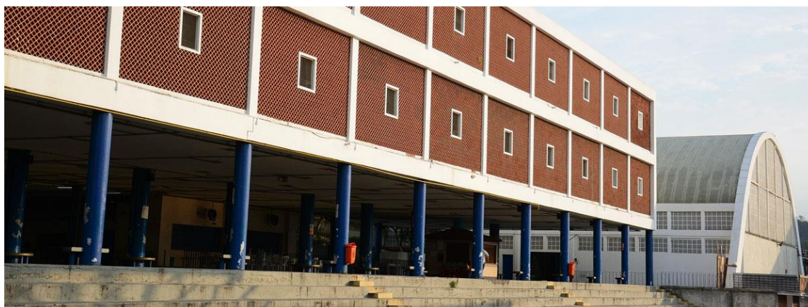
Figura 3 - Campus São Cristóvão III
