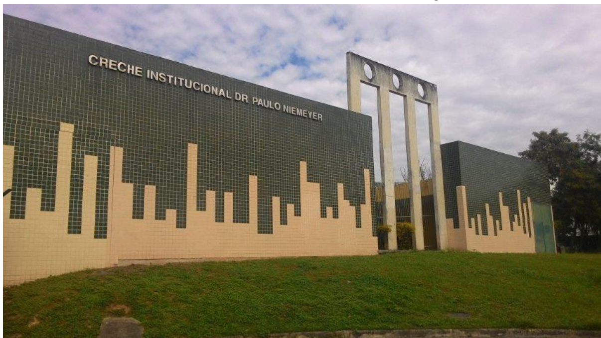
Figura 1- Fachada da Creche Institucional Dr. Paulo Niemeyer, localizada ao lado da sede da Prefeitura do Rio de Janeiro e em frente à Avenida Presidente Vargas.
