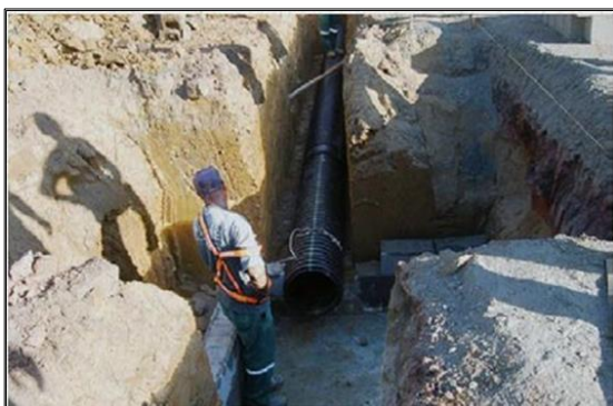
Figura 16 – Construção de Galeria
