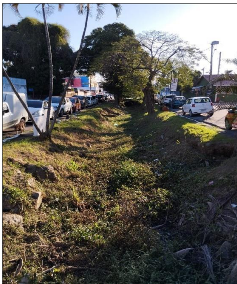
Figura 24 – Canal, próximo à Praça de Alimentação
