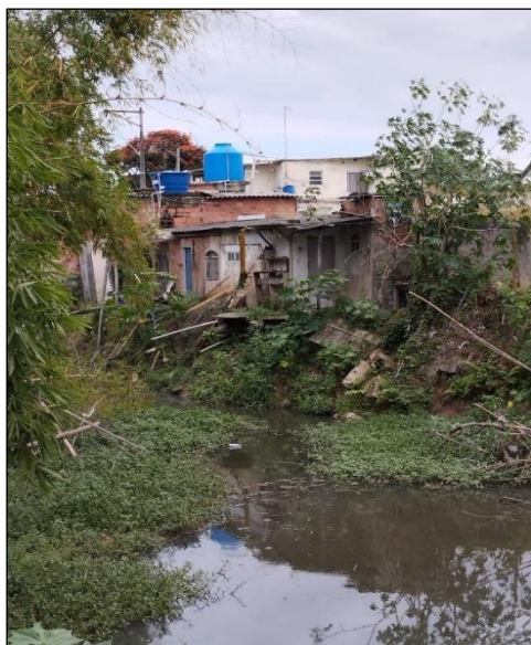
Figura 3 - Imóveis danificados, consequência de inundação do rio Mumbuca.
