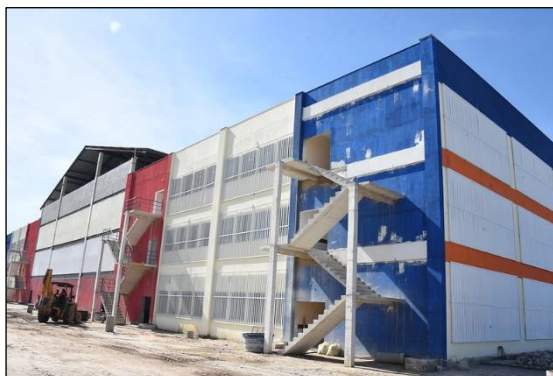
Figura 11 - Construção de edifícios.
