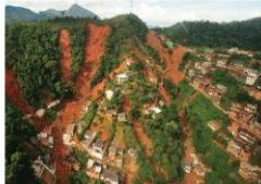
Figura (1): Ocupação de encosta em Friburgo onde ocorreram deslizamentos em 2011.
