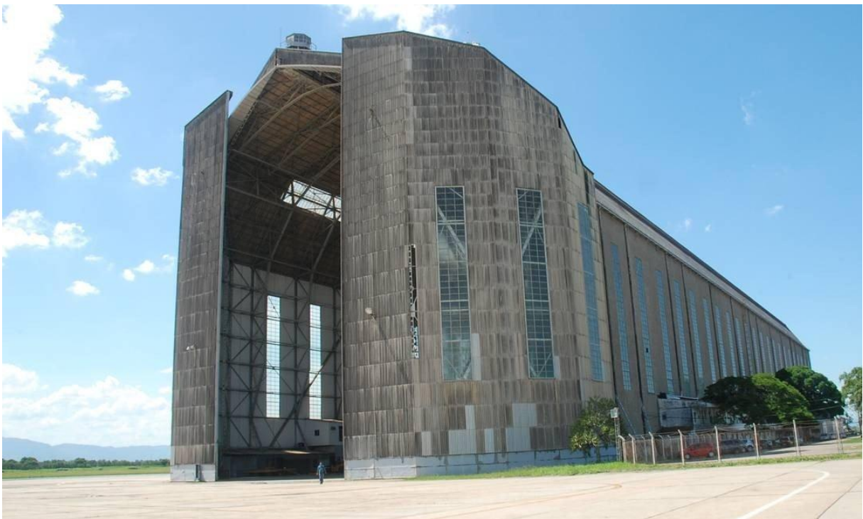
Figura 5 – Hangar do Zeppelin
